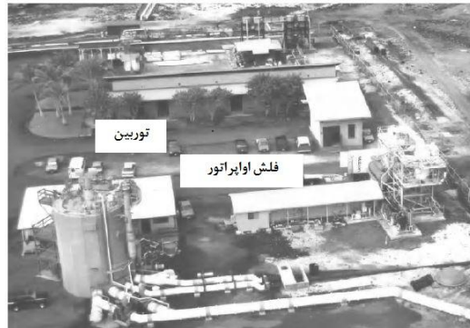
شکل ۱۳-۲ تصویر هوایی از نیروگاه آزمایشی چرخه باز OTEC
