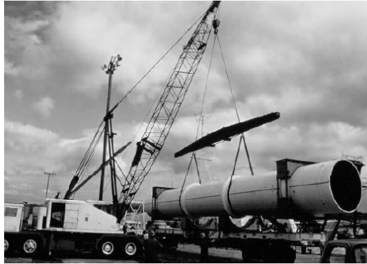
شکل ۱۲-۱۷ بخش ۱۲ m CWP به قطر ۲.۴ m در حال قرارگیری بر روی اسکله در بندر هنولولو؛ بخش‌های یکسان ۱۰ m به هم متصل شده و یک لوله را شکل می‌دهند (منبع: Luis Vega)
