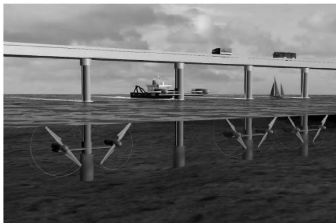
شکل ۷-۱۸ طرح "حصار جزر و مدی سه‌ورن"، با توربین‌های سیژن از MCT (منبع: MCT)
