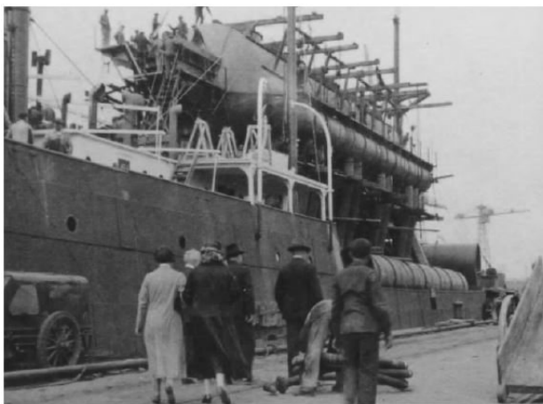
شکل ۱۲-۱۲ نیروگاه شناور OTEC Tunisia که در دایکوک مجهز می‌گردد
