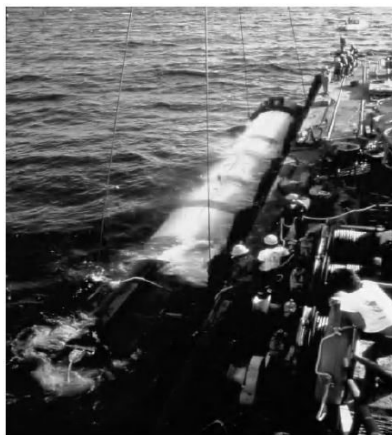
شکل ۱۲-۲۰ بخش ۱۲ m از CWP به قطر ۲.۴ m توسط تیم NOAA در حال قرارگیری در آب است؛ رابط نر، در پیش‌زمینه مشخص است و به یک انتها متصل است (منبع: Luis Vega)
