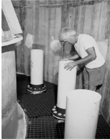
شکل ۱۲-۲۵ سه لوله‌ی PVC استفاده شده برای انتقال آب سطحی دریا به محفظه‌ی تبخیر روشن در حین عملیات (منبع: Luis Vega)
