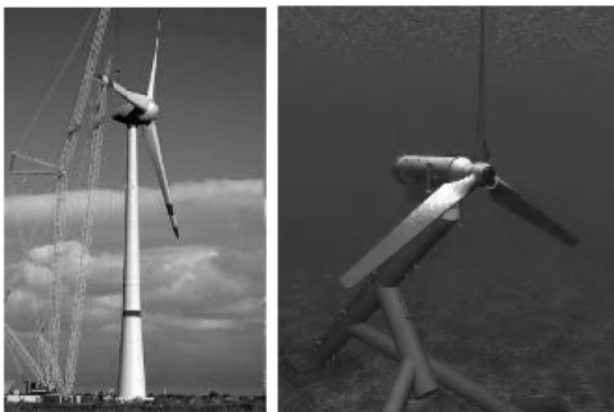
شکل ۱-۸ توربین بادی انرکن E126 (چپ) و توربین جزر و مدی همرفست استروم (راست) با جریان محوری
