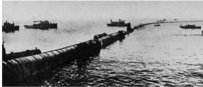
شکل ۱۱-۱۲ لوله‌ی به قطر 1.6\text{ m} و طول 2\text{ km} که دور از ساحل ماتانزاس شناور است و در آستانه‌ی قرارگیری توسط غوطه‌وری کنترل شده می‌باشد
