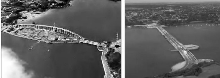
شکل ۹-۷ نمای هوایی نیروگاه برق جزر و مدی رنس: در حین احداث آن در ۱۹۶۴ و امروز (منبع: EDF)
