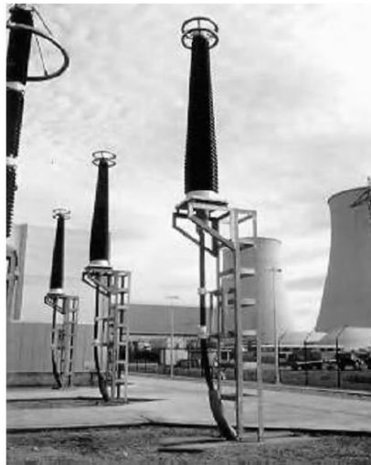
شکل ۷-۱۵ پایانه 400\text{ kV} با عایق چینی
