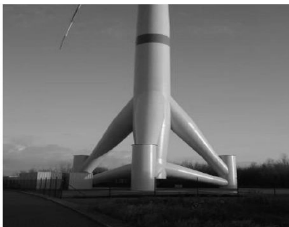
شکل ۵-۸ نمونه‌ی سه‌پایه نصب‌شده برای توربین بادی 5\text{ MW} در خشکی. اگر توربین در دریا نصب شده بود، این خط بیانگر سطح آب بود (عکس توسط نویسنده گرفته شده است)
