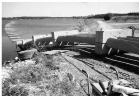
شکل ۳-۱۵ لوله‌های حفاظتی که قبل از کشیده شدن کابل 400\text{ kV} به داخل آن‌ها، در آبدره‌ای در حال قرارگیری می‌باشد [JEN 04]
