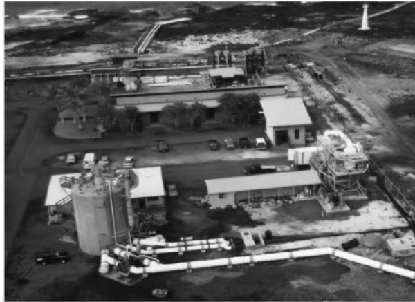
شکل ۱۲-۲۴ تصویر هوایی نیروگاه آزمایشی OTEC چرخه باز (در پایین تصویر)؛ مبدل‌های حرارتی و توربین درون ساختمان بتنی جا داده شده‌اند (منبع: Luis Vega)
