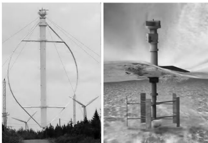
شکل ۸-۲ توربین بادی داریوس (چپ) و توربین جزر و مدی نیو انرژی (راست)، با جریان متقاطع و محورهای عمودی
